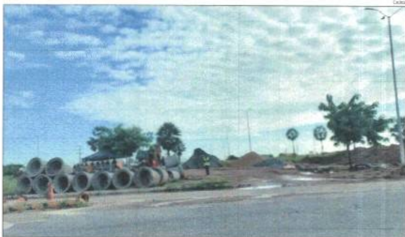
O tráfego no trecho foi desviado para a alça executada no canteiro
