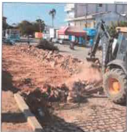
Obra de recuperação de ruas em Apodi está orçada em mais de R$ 260 mil
