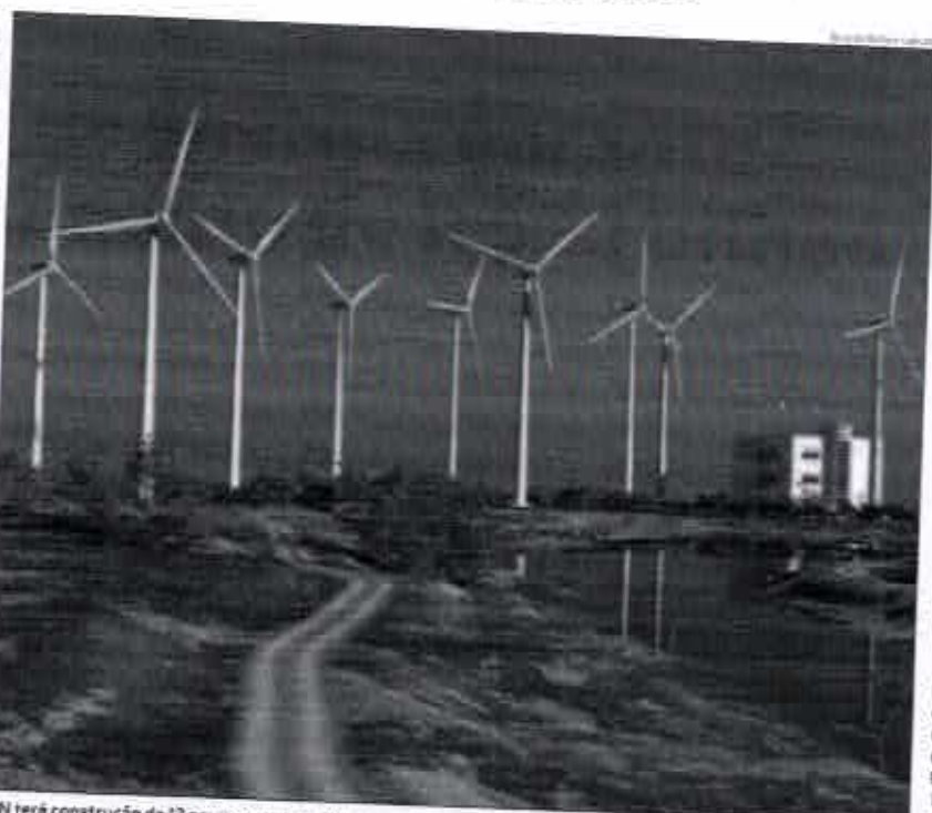
RN terá construção de 12 novos parques eólicos
