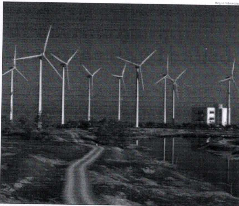
RN terá construção de 12 novos parques eólicos
